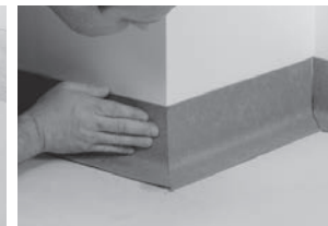
Appliquer les plinthes HSLA. Bien appuyer.
