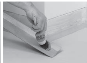
Appliquer la colle sur le sol et contre le mur jusqu'à la ligne.
