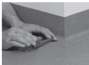
Découper le revêtement qui sera posé par-dessus la plinthe.
